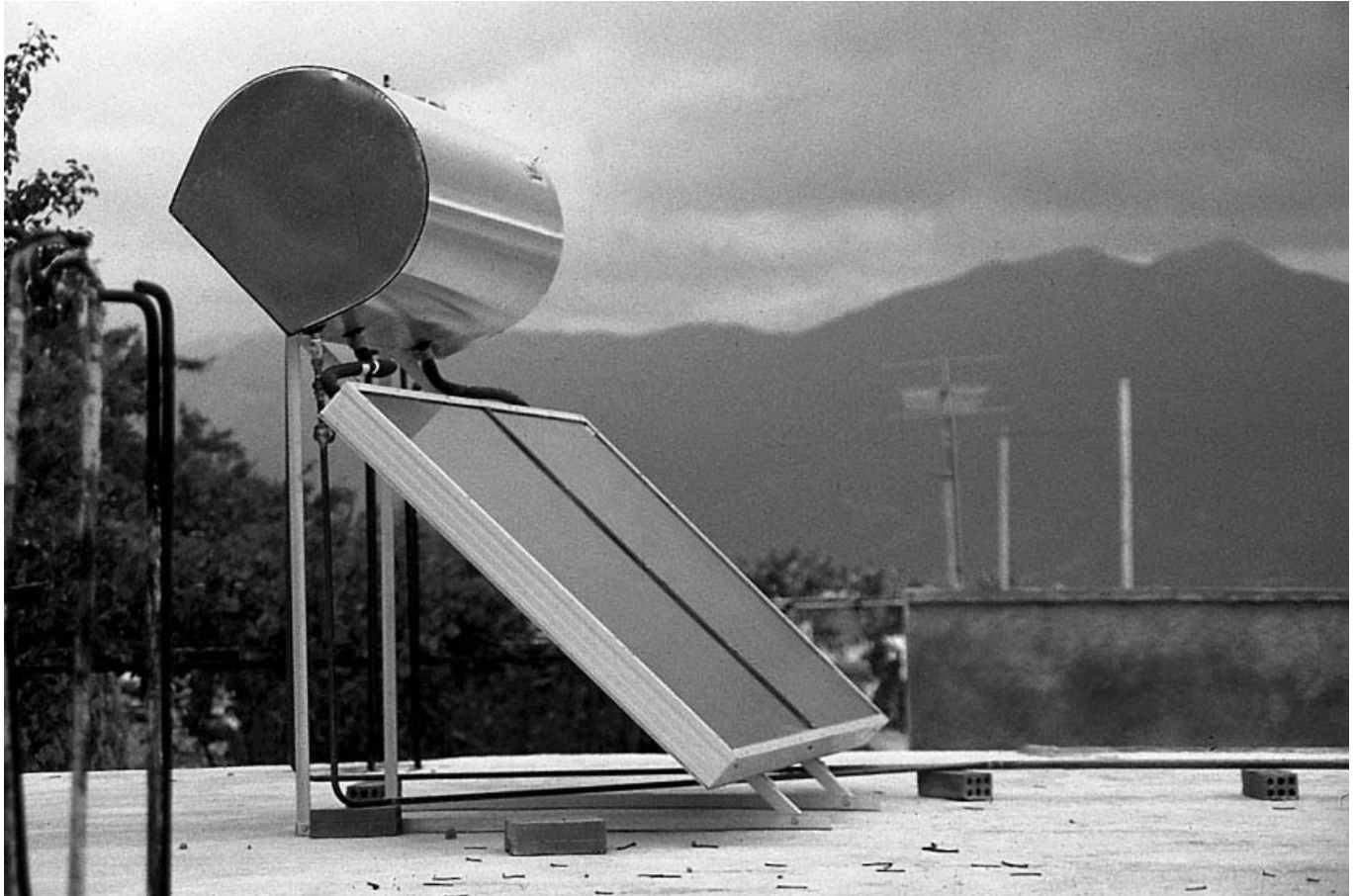
CES pour la production d'eau chaude sanitaire
