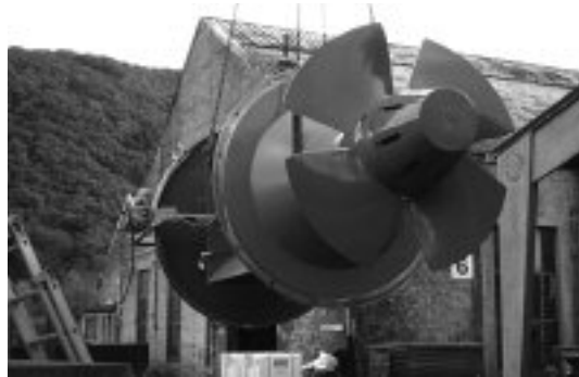
Mise en place de la nouvelle turbine Kaplan
