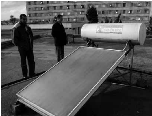
Chauffe-eau solaire sur le toit du centre de formation, ... non entretenu et donc en panne !
