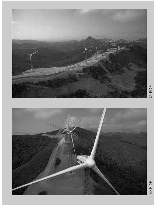
Parc éolien de Koudia Al Badia, composé de 84 éoliennes de 600 kW dont le diamètre est de 42 m et la hauteur des mâts de 40 à 45 m. (EDF)
