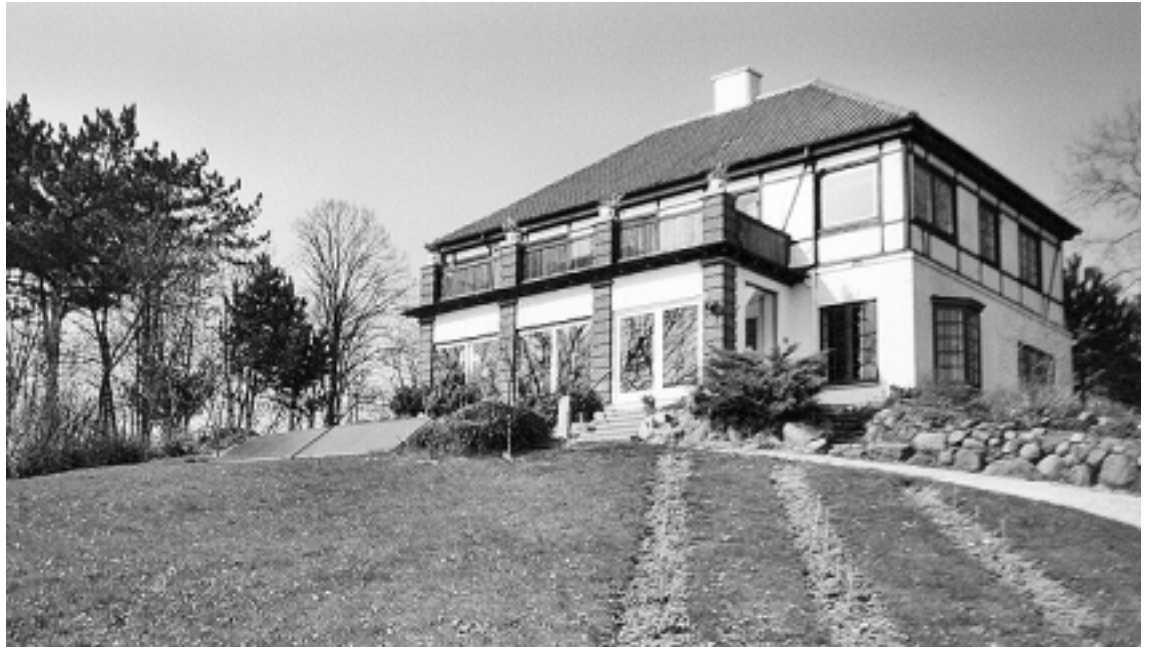
De la plus petite à la plus grande demeure, partout, des utilisateurs de panneaux solaires
